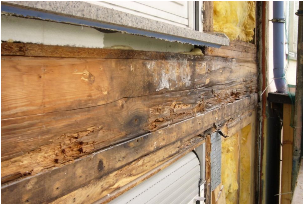
Ansicht der Holzkonstruktion nach dem Entfernen des Außenputzes
