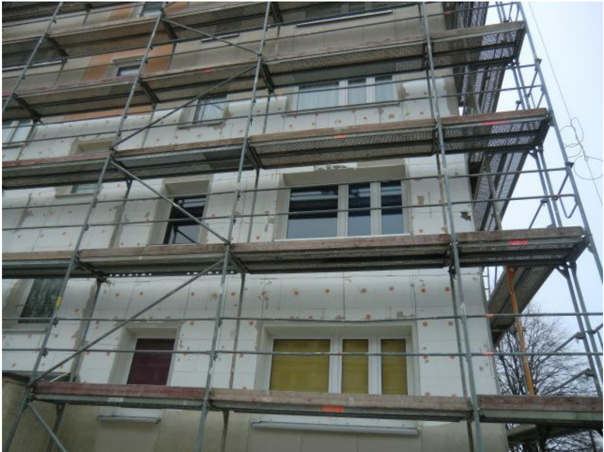
Foto 3 – Ansicht des Polystyrols ohne Reste der Spachtelung
