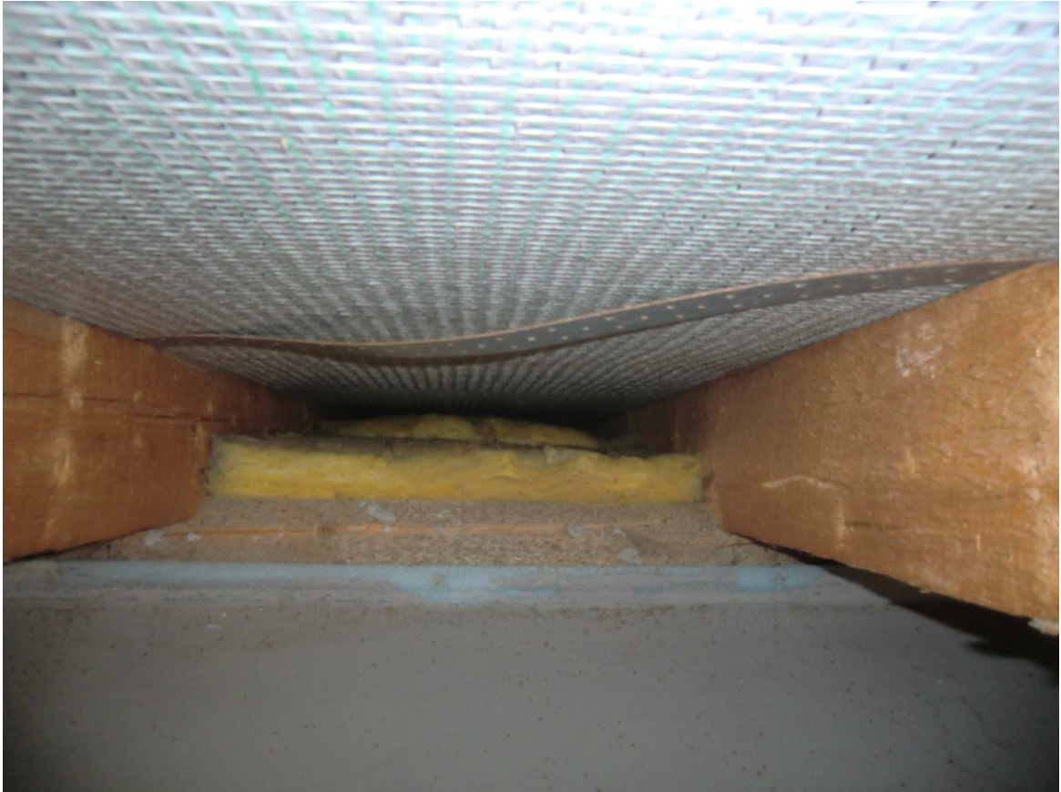
Foto 4 – Zwischensparrendämmung mit der Möglichkeit der Hinterlüftung
