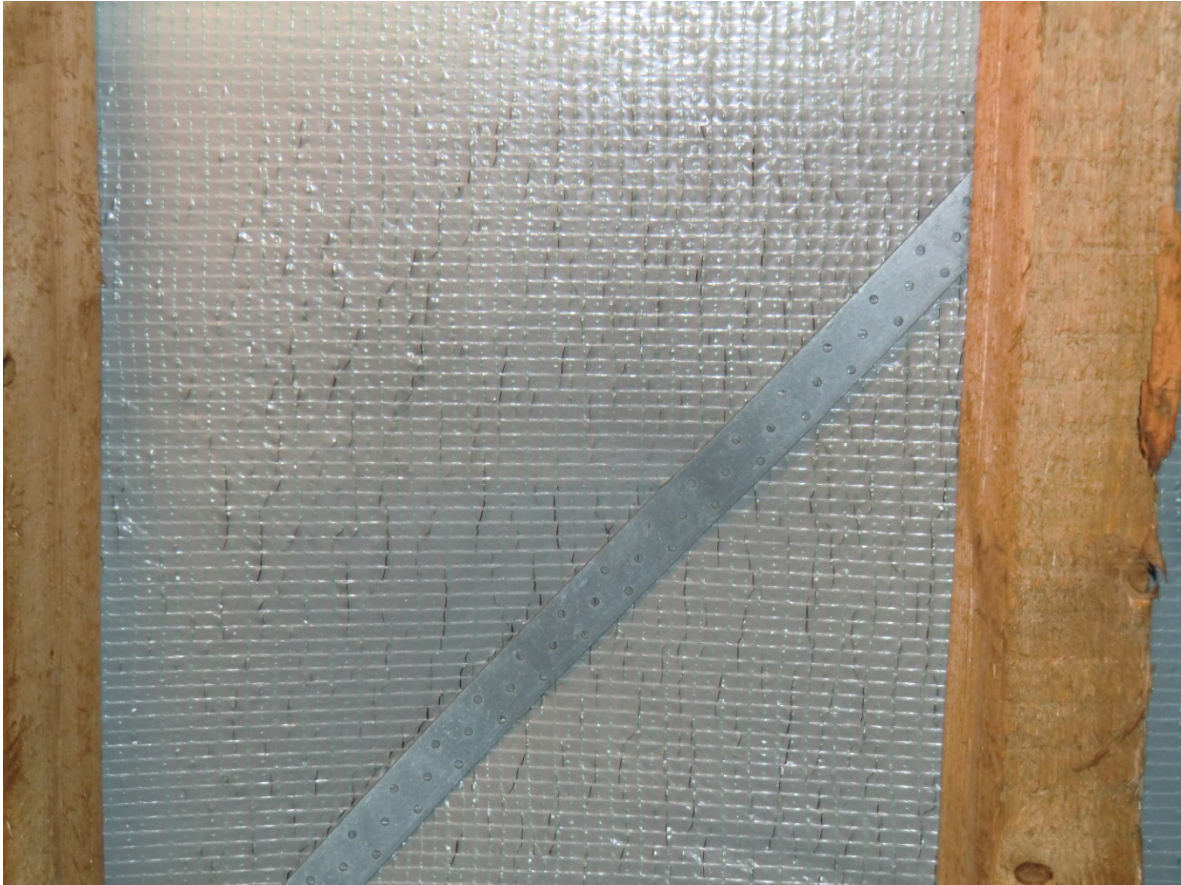
Foto 2 - Poröse und rissige Unterspanbahn im Spitzboden ( Nahaufnahme von Foto 1 )
