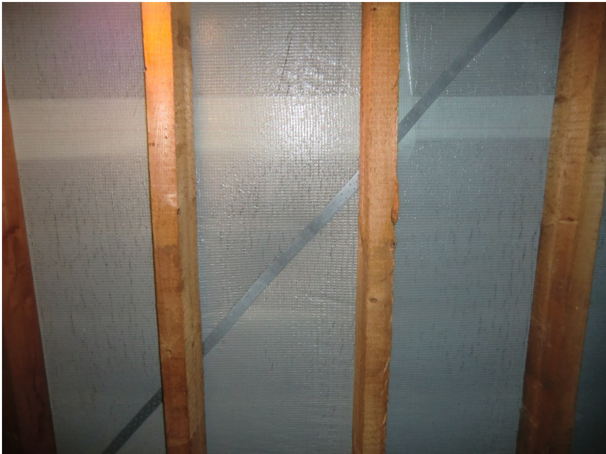
Foto 1 - Poröse und rissige Unterspannbahn im Spitzboden
