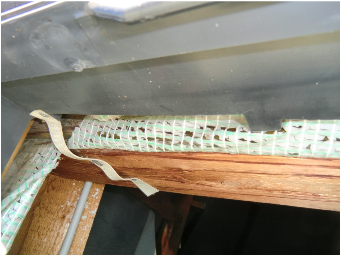
Foto 3 – Stark geschädigte Unterspanbahn im Bereich der Dachausstiegsluke
