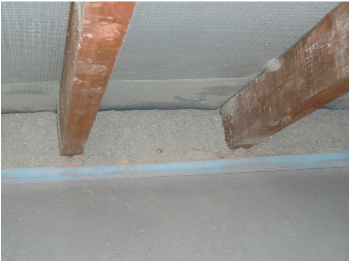
Foto 5 – Vollsparrendämmung mit eingeblasener Zellulose
