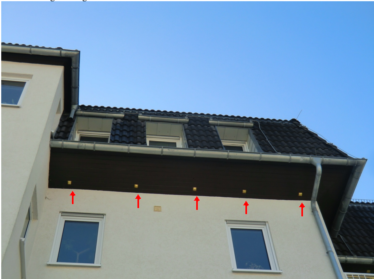
Foto 7 – Kleine Belüftungsöffnungen am Dachkasten ( rote Pfeile )
